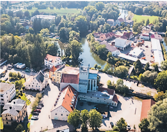
Für das Areal rund um die Aumühle und Lände soll nun ein Rahmenplan erarbeitet und Möglichkeiten einer Vermarktung geprüft werden.
