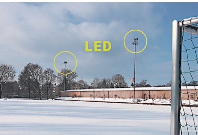
Die Flutlichtanlage auf dem SCF-Gelände soll auf stromsparende LED umgerüstet werden.
